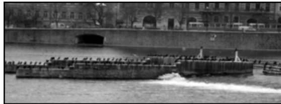
Hejno kormoránů na propusti jezu u Karlova mostu.
