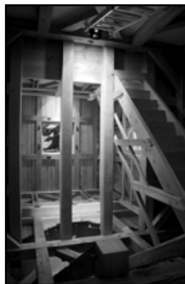
Schody do hlavní věže.
