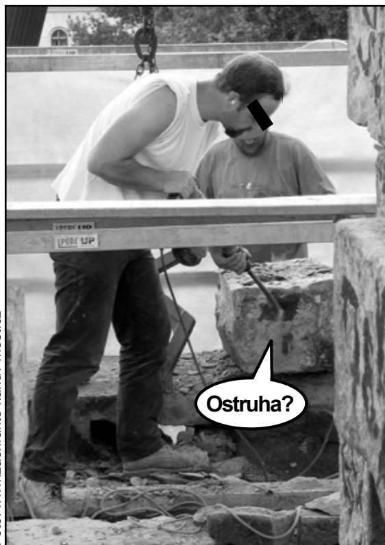
Dělníci se sbíječkou na Karlově mostě.
