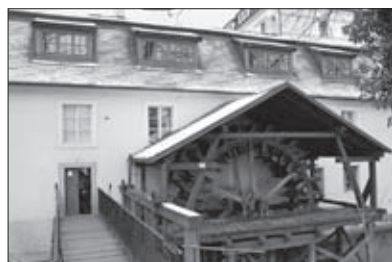
KAVÁRNA Mlýnská, vchod z parku Kampa.
