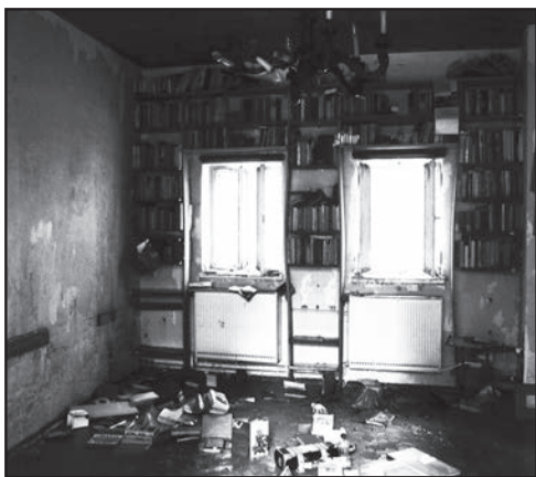
Knihovna ve Velkopřevorském mlýně. Všimněte si, že dolní řada knihovny je vyklizená. Voda zasáhla až tu horní řadu. Škody velké.
